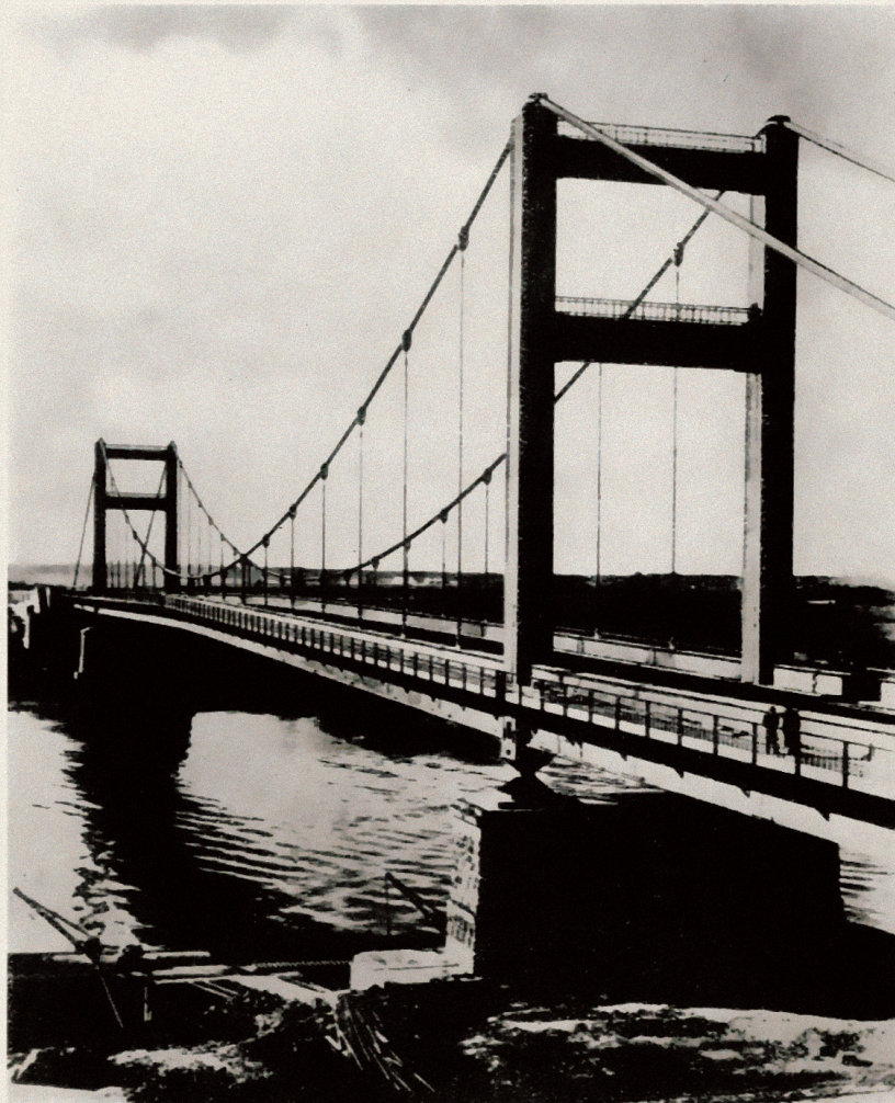
58. Die neue Straßenbrücke über die Save zwischen Belgrad und Semun (BB 7740)
